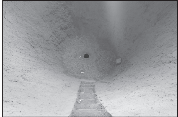
تصویر ۷. پله‌های درگاه جنوبی یخدان که تا کف امتداد دارد. در تصویر روزنه چاه جذبی کف مخزن مشخص است (عکس از: سلطانی).
