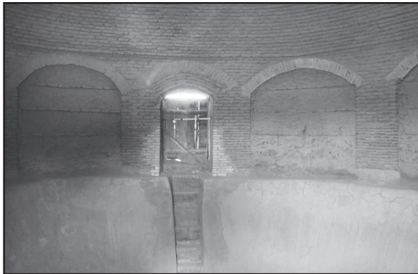
تصویر ۸. پله‌های درگاه شمالی مخزن که یخ‌ها از طریق آن به درون مخزن ریخته می‌شد (عکس از: سلطانی).
